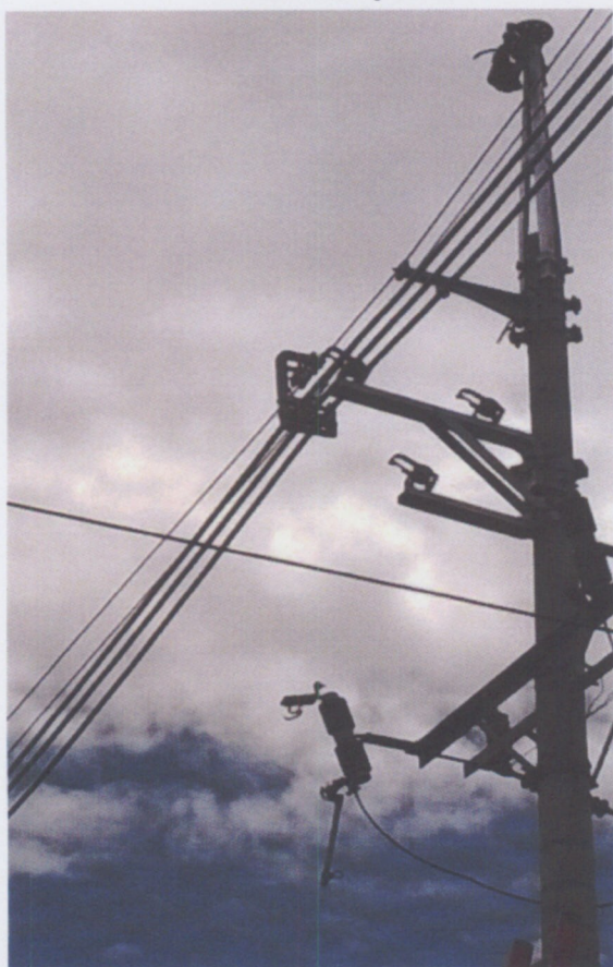
Figura N°11: Trabajos de instalación de la Línea compacta
