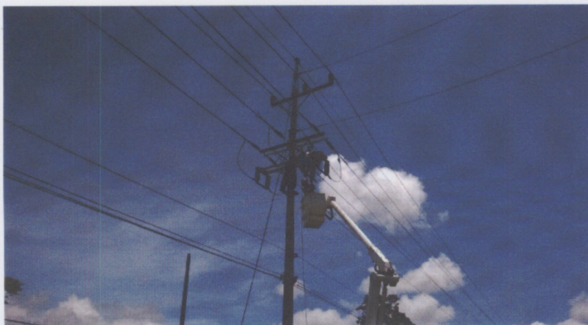
Figura N°9: Trabajos previos a la instalación de la línea compacta
