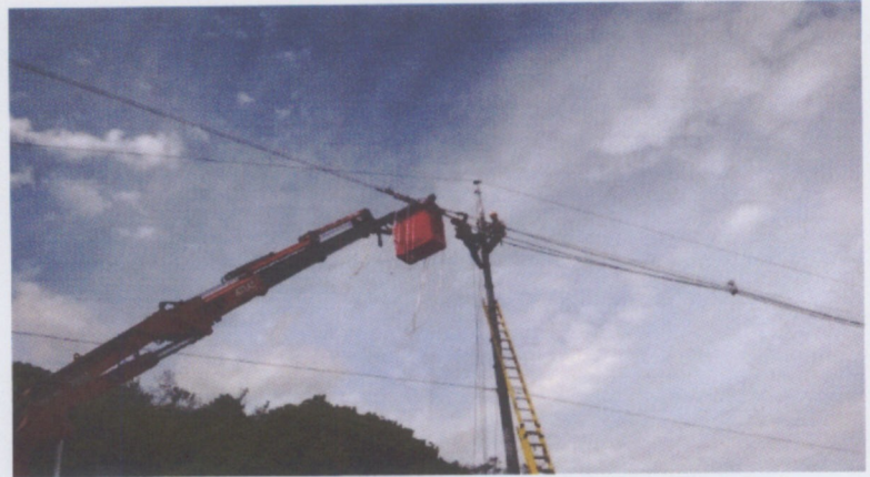
Figura N°7: Tendido de la línea compacta Figura N°8: Tendido de la línea compacta
