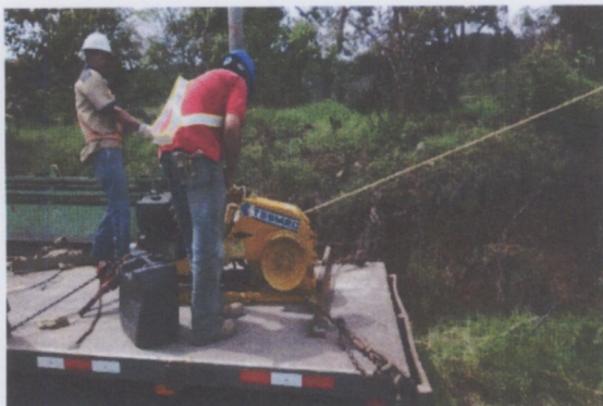
Figura N°6: Funcionamiento del cabrestante.
