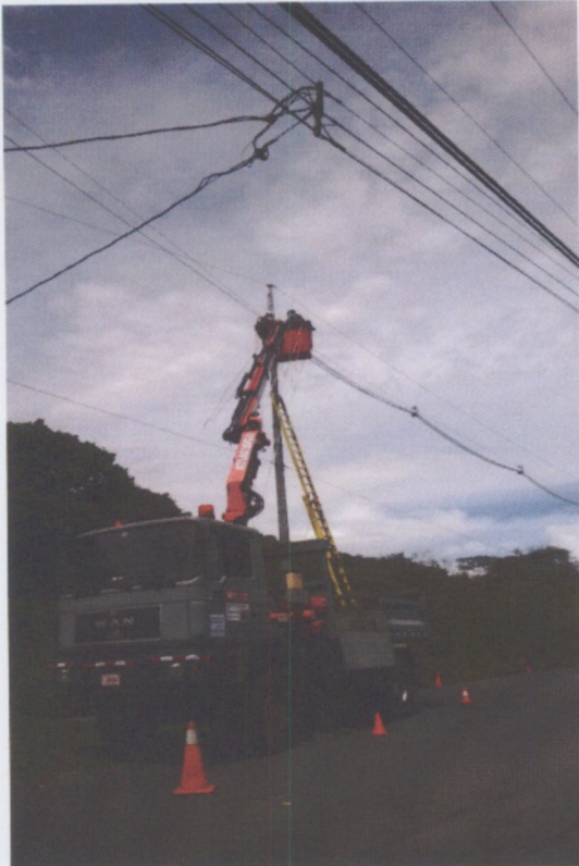
Figura N°7: Tendido de la línea compacta Figura N°8: Tendido de la línea compacta
