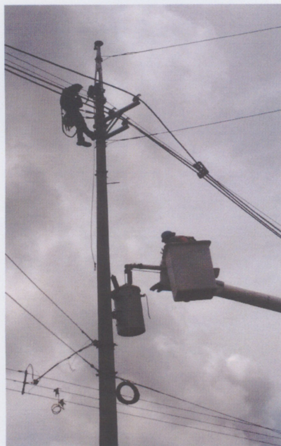
Figura N°12: Trabajos de instalación de la línea compacta
