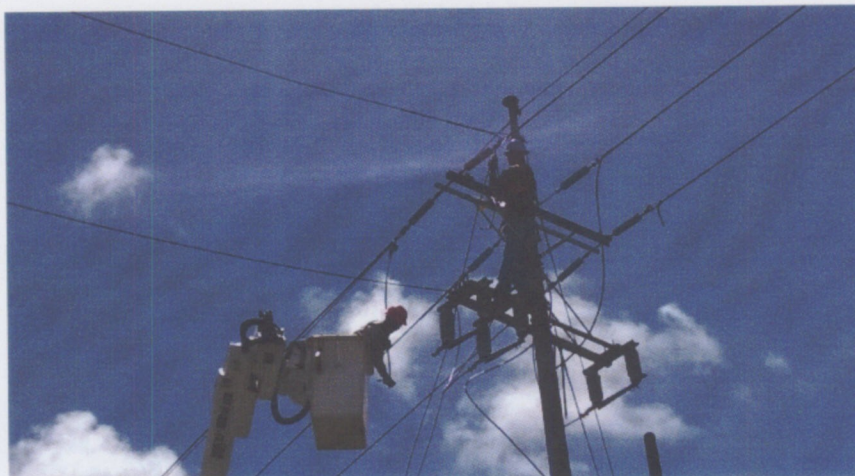
Figura N°10: Trabajos previos a la instalación de la línea compacta
