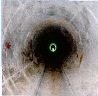
Túnel de conducción 4744.0 m de longitud
