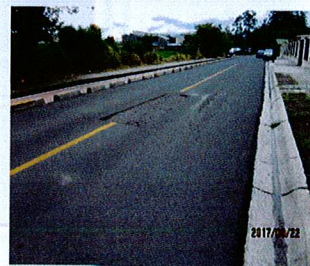
Trabajo realizado por la empresa MECO: Bacheo de zona en la que se detectó agrietamiento Ubicación: Entre los pozos B 723 – B 724 Transversal 13 – San Agustín, Frente a Centro Diurno
