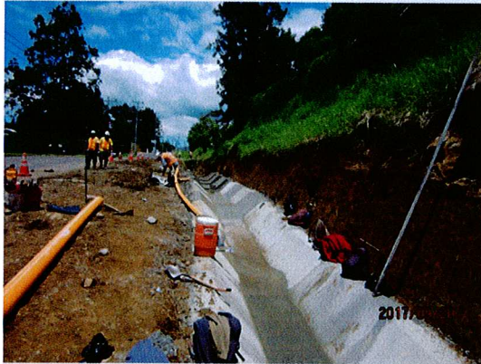
Trabajo realizado por Constructora MECO (Construcción de Canal Trapezoidal).
