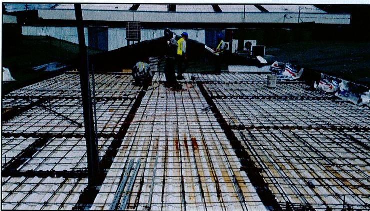
Armado de estructura de entrepiso
