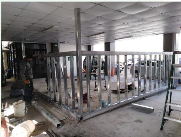
Construcción en parqueo del Edificio Central.
