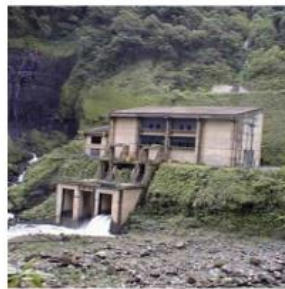
Octubre 1996 Río Toro , Río Segundo, Río Claro, Río Pozo Azul y Quebrada Latas Caudal de 20 m3/s
