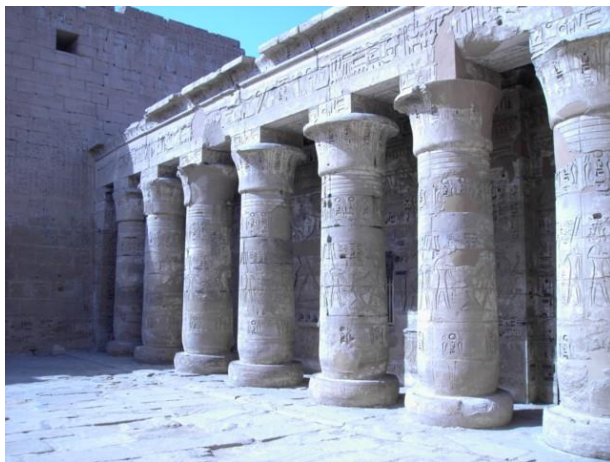
Los pilares son el soporte de las estructuras
